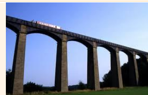
Pontcysyllte Aqueduct - Llangollen Wales
